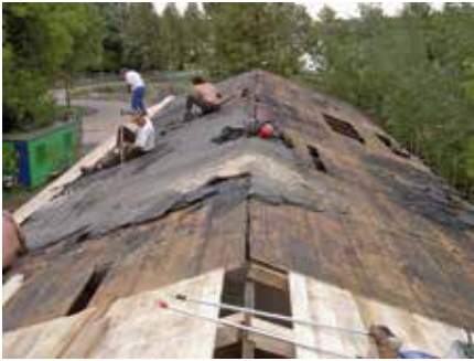
Das Dach wird neu gedeckt. 2007
