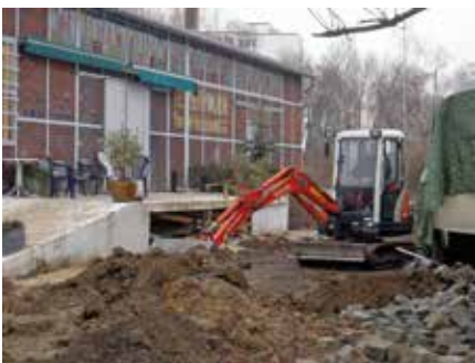
Wasserrohre werden gelegt. 2008
