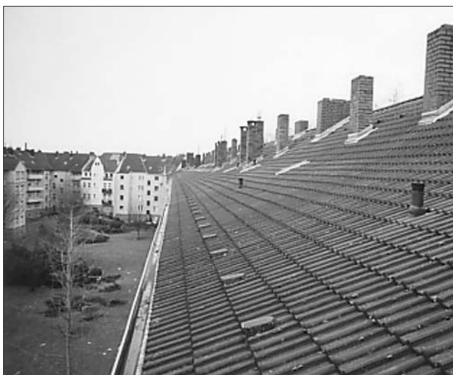
Gefällte Bäume, sanierte Dächer
