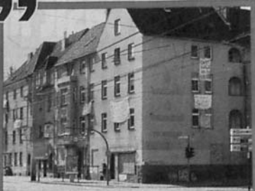
Tag 20 der Abriß-Demo. 100 Teilzeit-Besetzer sollen es bereits im Barmer Block sein
