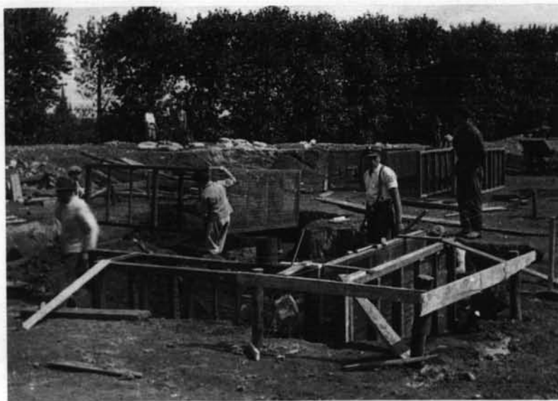
Die Arbeit war ungewohnt für die Männer, die sich selbst ihre Häuser bauten. Mittags kam der Essenträger (oben). Nach der schnellen Mahlzeit wurde weiter geschuftet; oft bis zum Einbruch der Dunkelheit.
